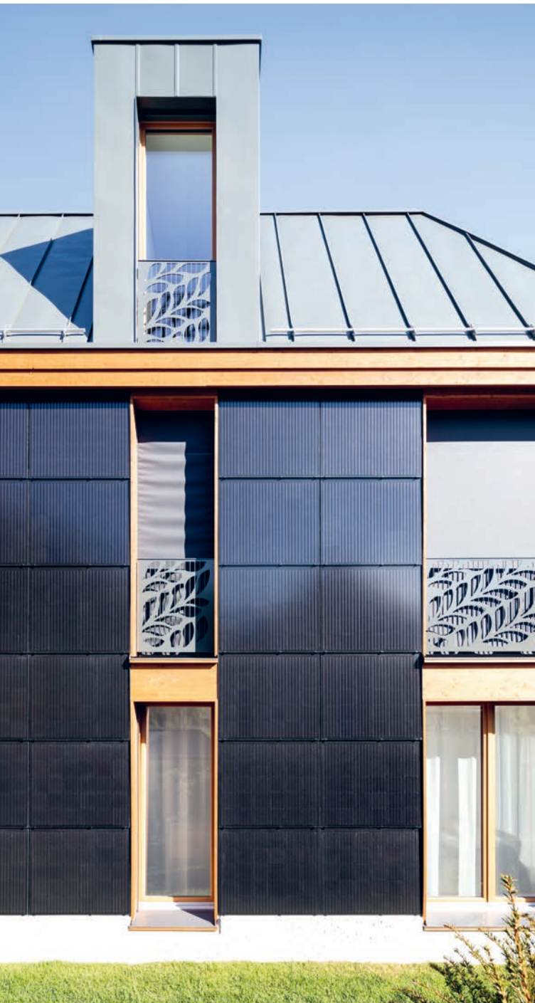
Fenster und Lukarnen harmonisieren perfekt.
