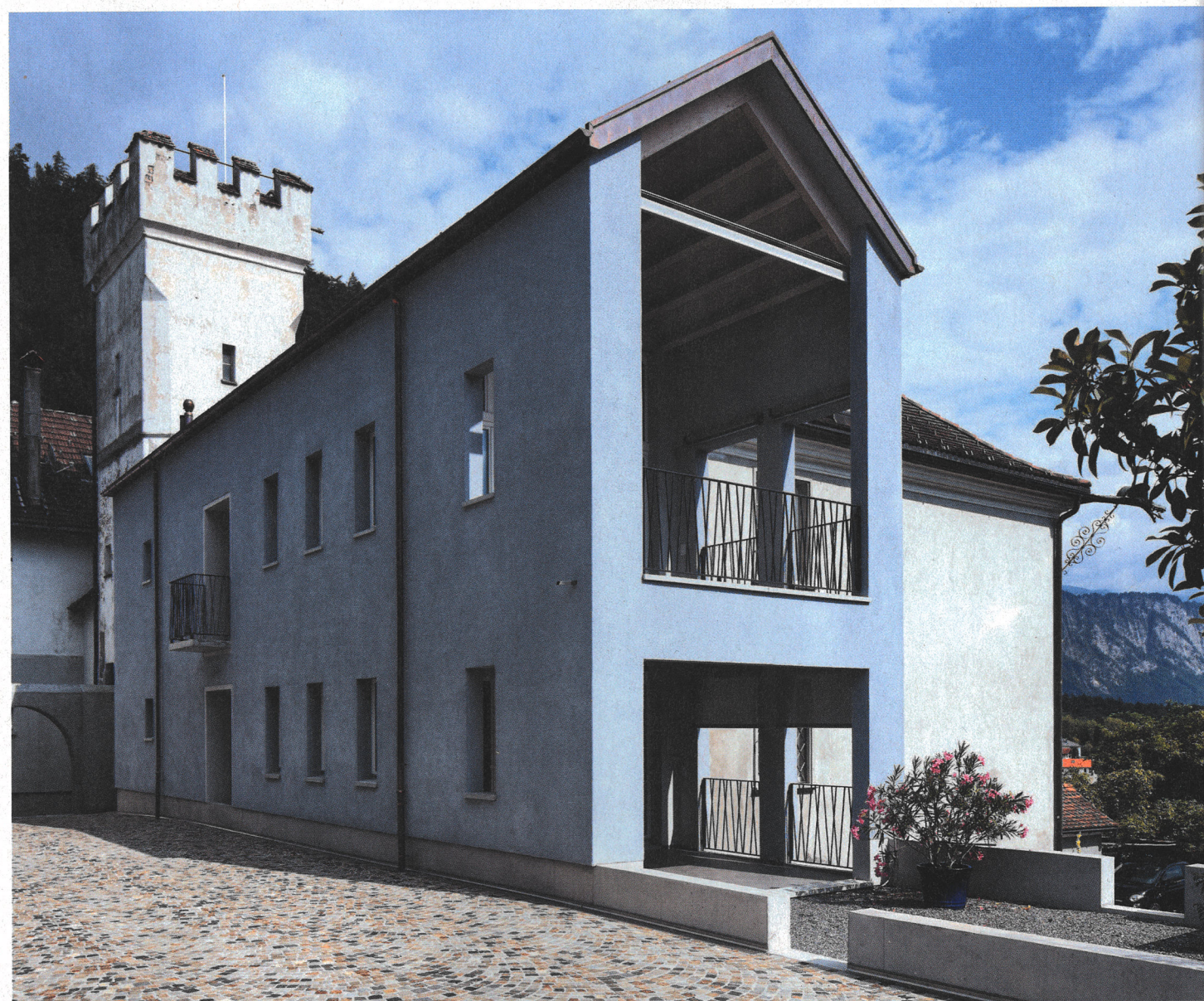
Blick vom alten Anbau zum neuen.
