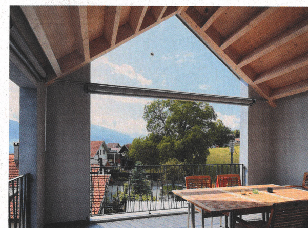
Im Gartenzimmer bleibt der Holzdachstuhl sichtbar.
