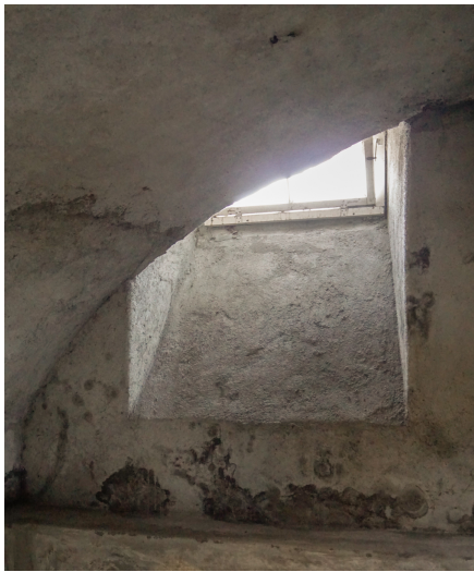
Abb. 5 Foto Gewölbe | Fenster Kellergeschoss
