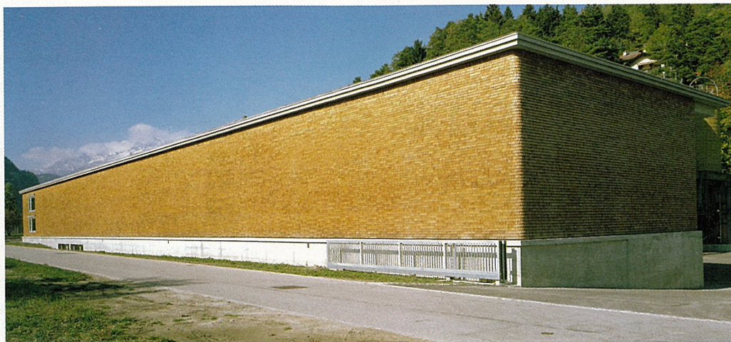
Werkhof, Ilanz GR: Mehr als ein Lastwagenstall.
