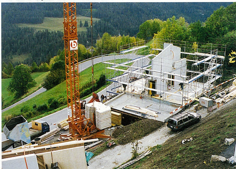
Bauen am Hang: Ein Betonsockel verankert das Gebäude im Terrain.
