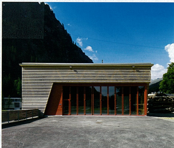
サフィエン木材工場 | Forstwerkhof Safien
