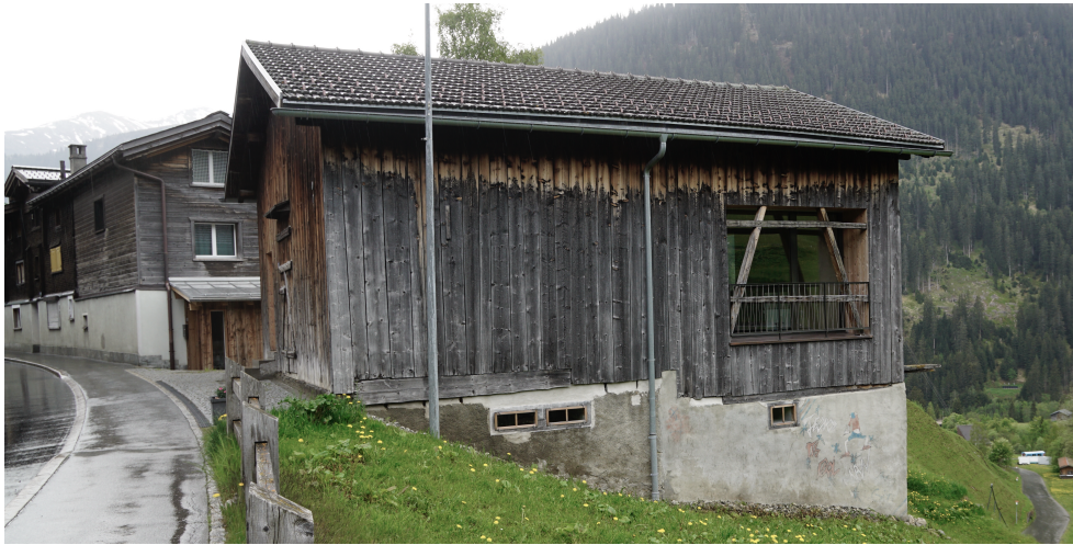
Abb. 8: Umbau in Camischolas mit neuen Fensteröffnungen und sichtbarer Tragkonstruktion
