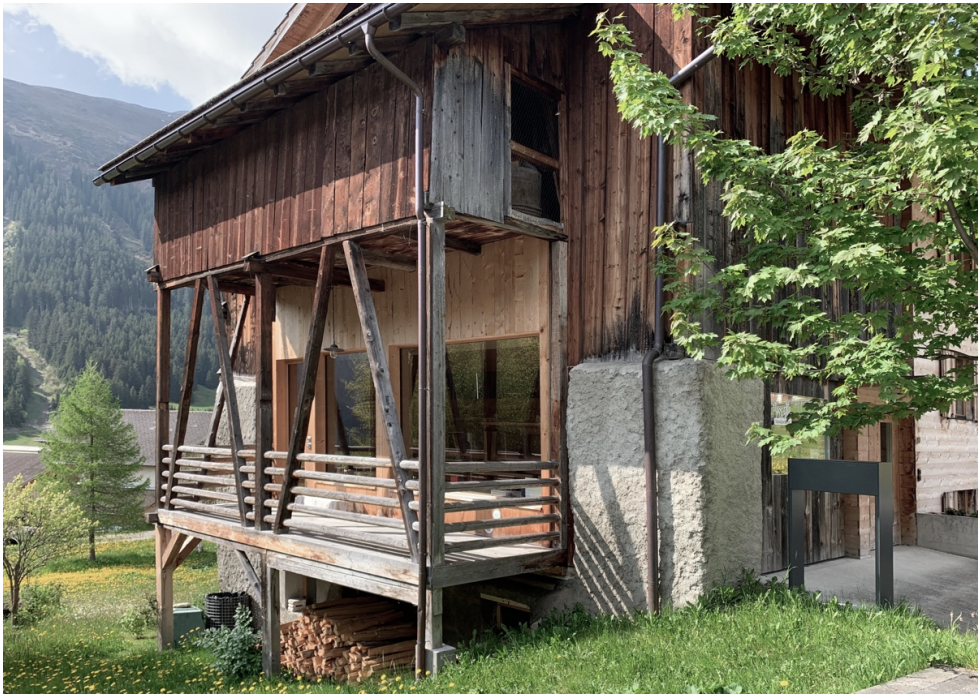
Abb. 9: Umbau in Rueras mit geöffneter Holzkonstruktion am Anbau, sichtbarer Tragkonstruktion und dahinterliegender grossflächiger Fensteröffnungen
