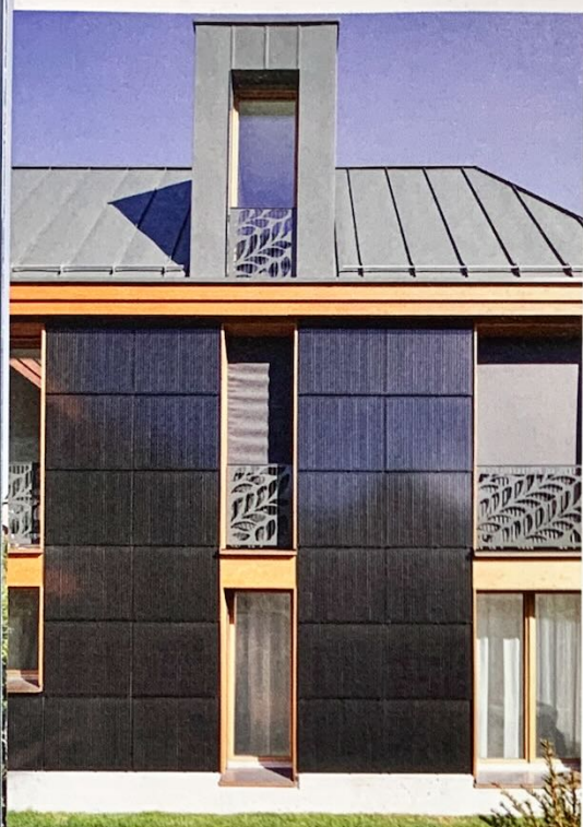
Der Übergang von der Fassade zum Dach ist mit einer eingelegten Rinne bewerkstelligt.
