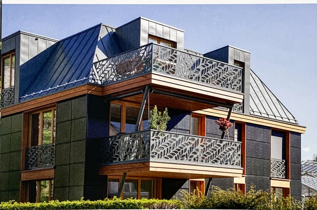
Die Photovoltaik-Fassade ist nach Süden und Westen orientiert. (Bilder: Dorn AG)
