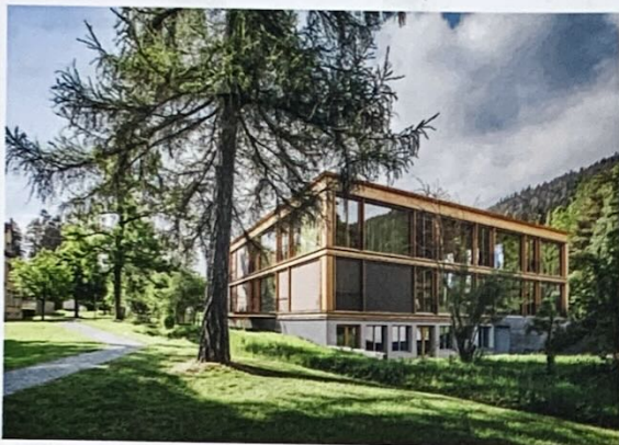
Der Pavillon im Park der Klinik Beverin könnte auch ein Neubau sein.
