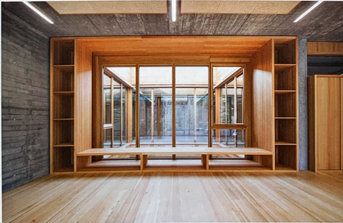
Das neue Atrium bringt mehr Licht in die Räume. Decken, Stützen und wenige Wände aus Beton stammen noch vom ursprünglichen Gebäude.
