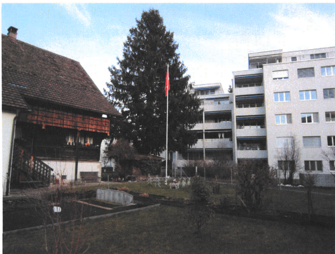
Folgen der «unkontrollierten» Verdichtung.
