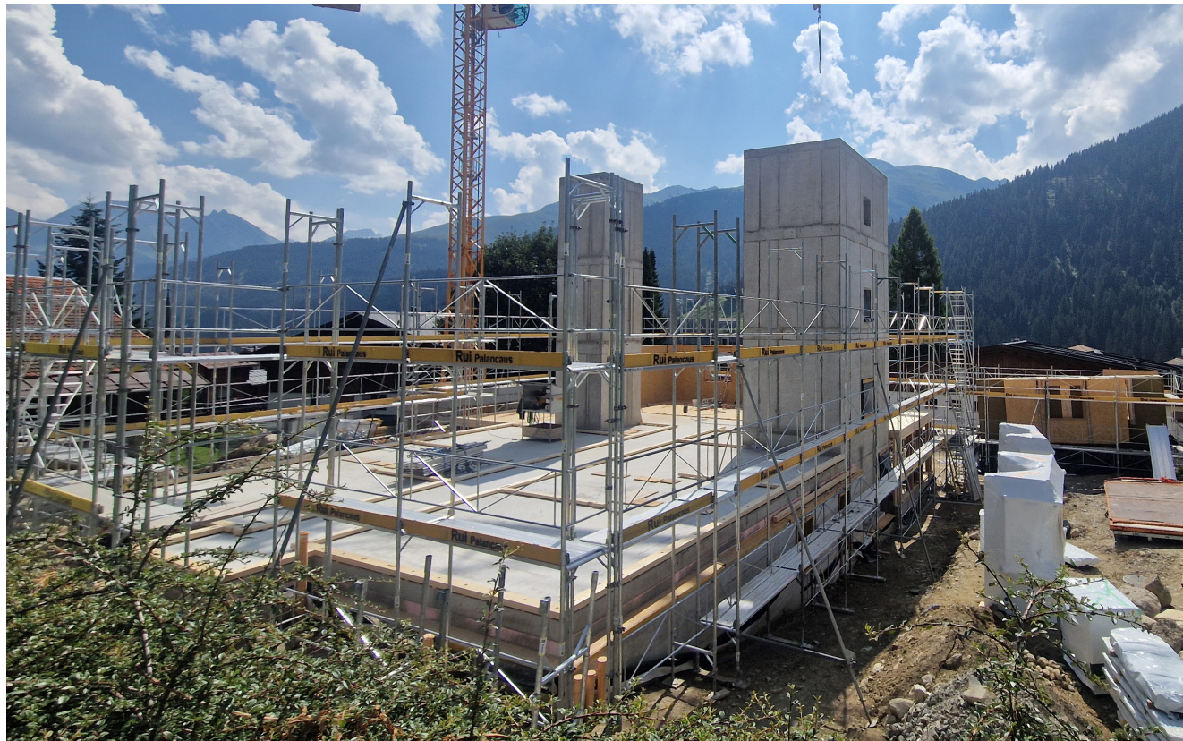
Zwei Betontürme sichern die Erdbebensicherheit und die Windaussteifung
