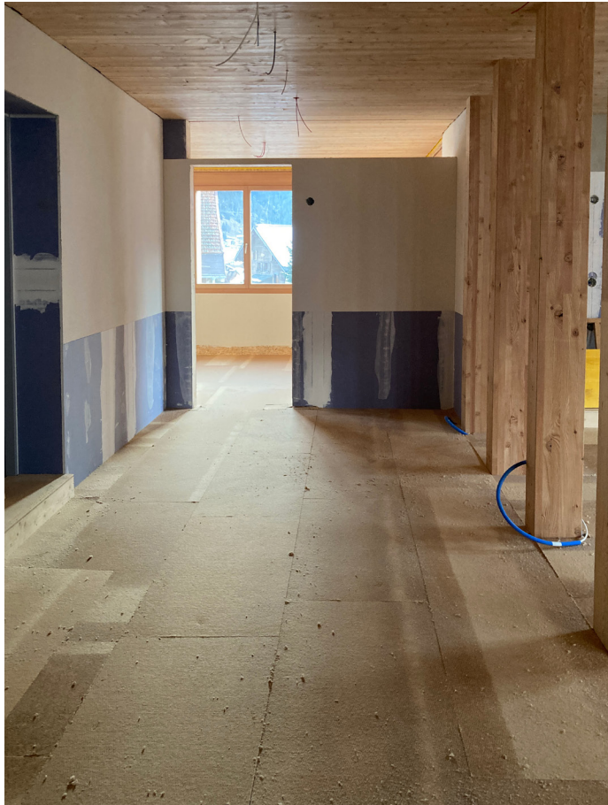
Holzfaser als Trittschall- und Bodendämmung
