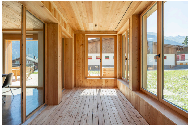
Ungedämmter Balkon, der als Wintergarten genutzt werden kann
