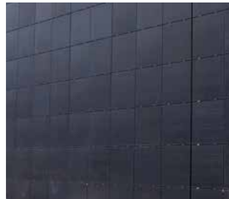
Fig. 1 : gros plan sur la nouvelle façade solaire du site SIG au Lignon.
