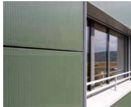
Abb. 1: Die solare Fassade besticht durch den Grünton. Dieser konnte durch die Verwendung von speziellen PV-Modulen erreicht werden.
