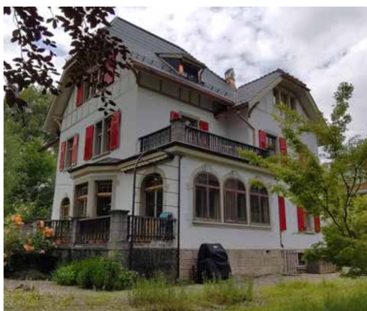
Abb. 4: Bei der Sanierung der Villa wurde nicht nur eine Photovoltaikanlage auf dem Dach installiert, vielmehr wurden auch das Gebäude selbst energetisch saniert und auf den neuesten Stand gebracht.
