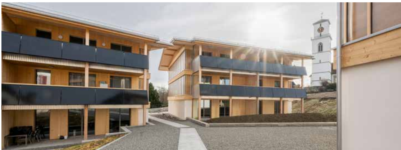
Abb. 2: Bei der Alten Schmitte wurde nicht nur das Dach mit PV-Modulen bestückt, sondern ebenfalls die Balkonfassaden, um möglichst alle geeigneten Flächen zu nutzen (Bildquelle: Reto Martin, https://www.retomartin.ch ).
