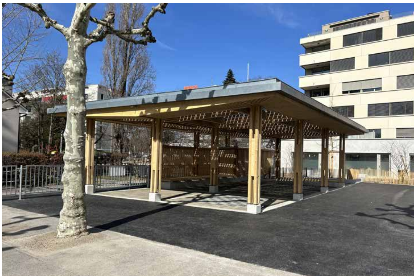
Fig. 3 : grâce à l'utilisation de modules photovoltaïques bifaciaux, l'avent de la cour de récréation produit non seulement de l'énergie sans émissions pour l'école, mais permet également une grande transparence à la lumière.
