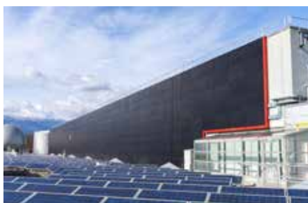
Fig. 2 : Stockage/Dépôt SIG, Le Lignon/GE.
