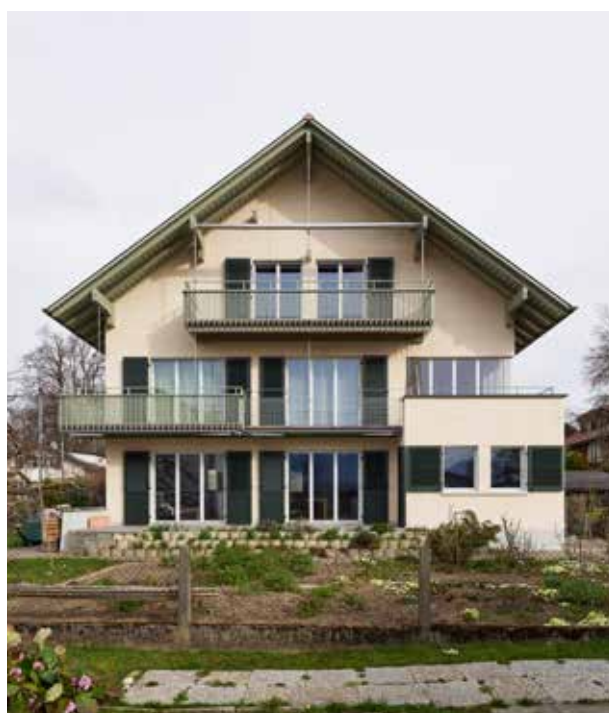
Abb. 4: In den Giebelfassaden gibt sich die Grenze zwischen Bestand und Erweiterung subtil zu erkennen. Vergrösserte und neue Fenster bringen mehr Tageslicht und passive Gewinne. Ein gestalterischer Erfolg!
