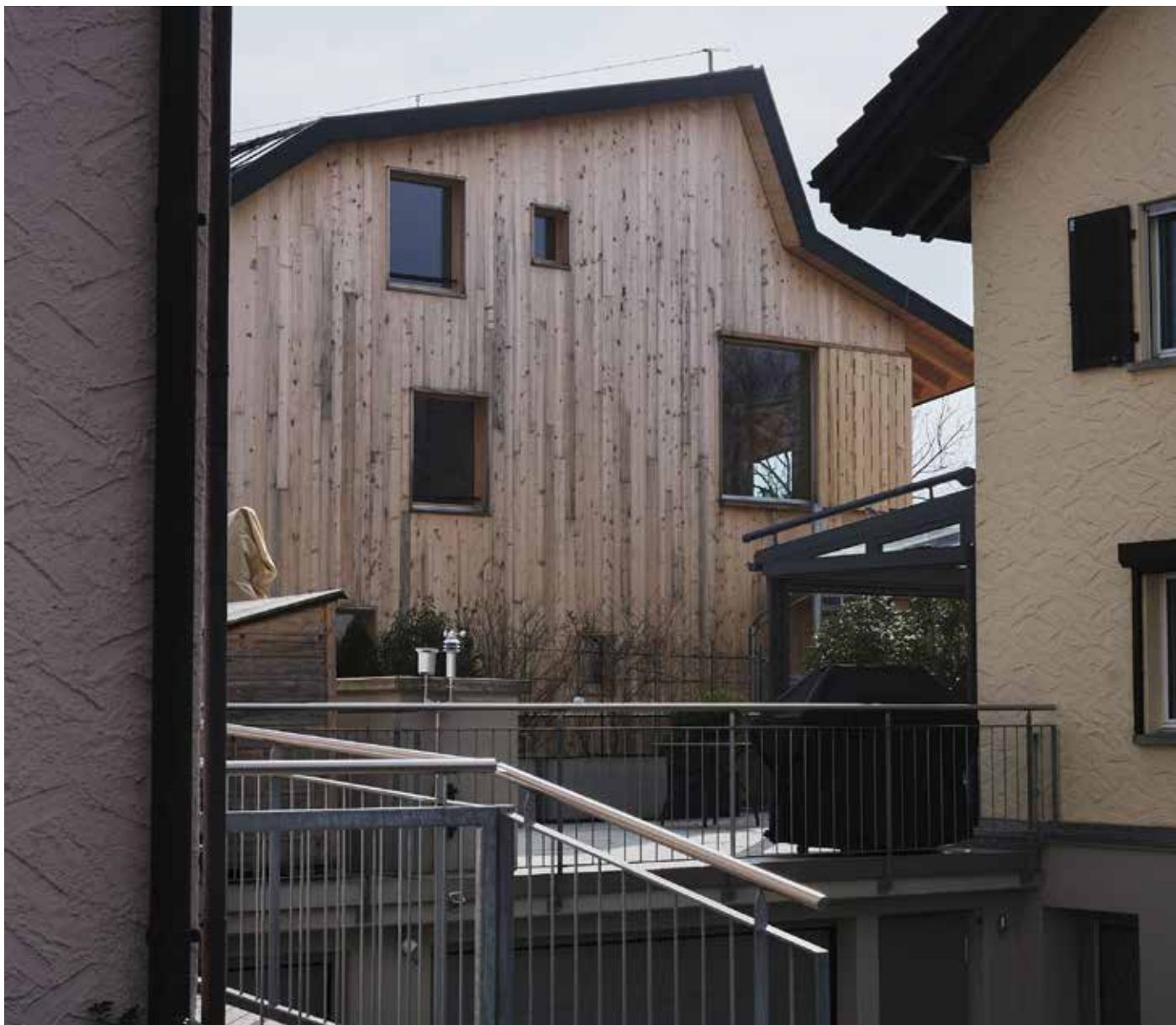
Abb. 2: Das MFH schliesst sich harmonisch in die bereits vorhandene Gebäudestrukturen ein.
