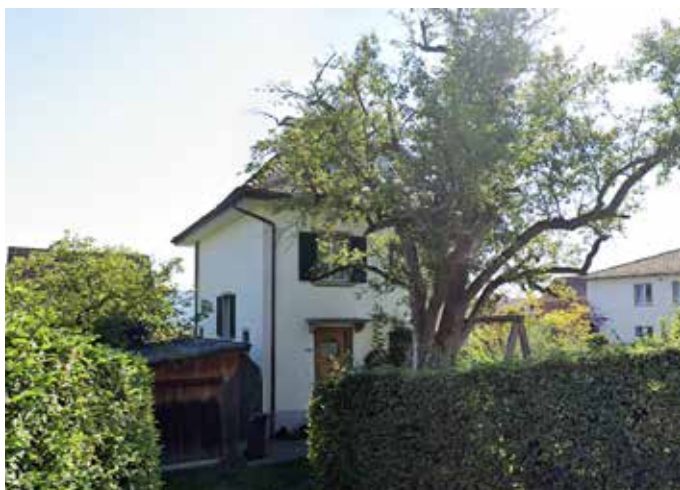
Abb. 5: Das Einfamilienhaus von 1924 wurde 2013 mit Aerogel energetisch saniert und mit einer Wärmepumpe versehen, ist ebenfalls physisch in den ZEV integriert.
