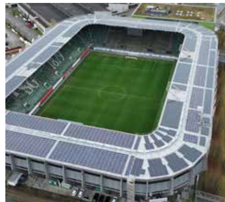
Abb. 1: Im Kybunpark kann man nicht nur Sportevents beiwohnen; man ist gleichzeitig in einem solaren Kraftwerk.
