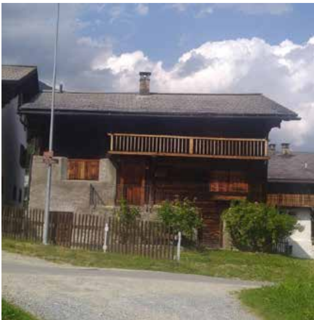
Abb. 3: Das Gebäude vor der Sanierung.
