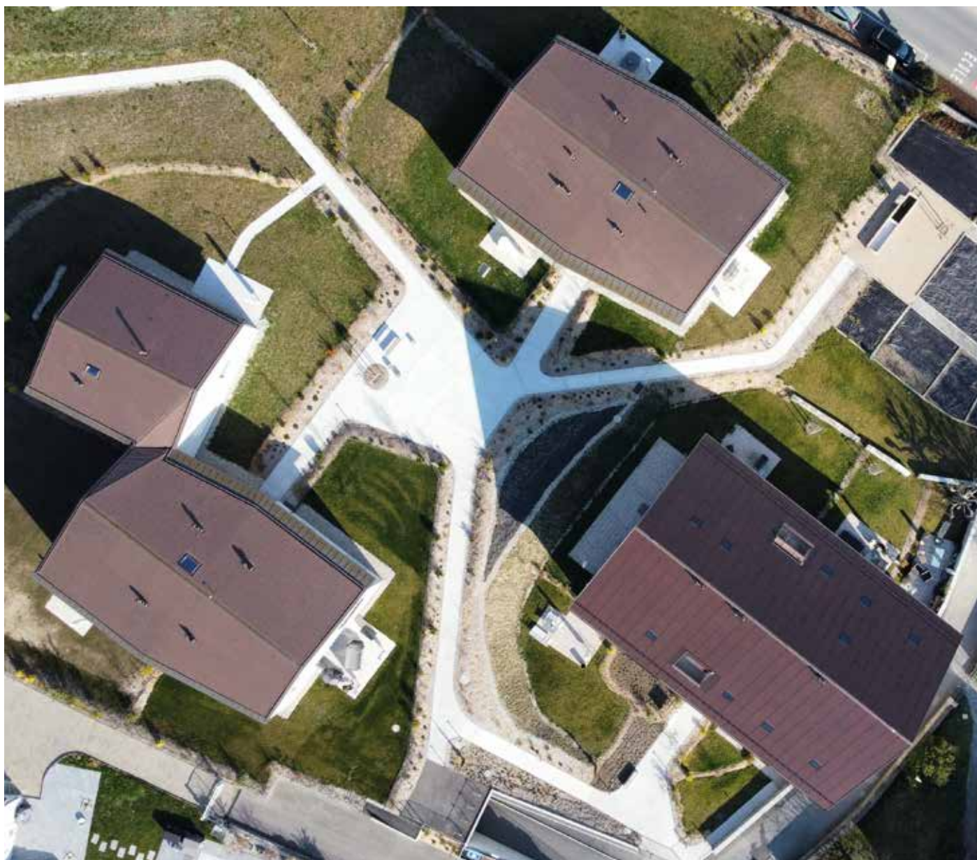
Fig. 3 : vue aérienne de l'ensemble du complexe immobilier : celui-ci se compose de quatre bâtiments, tous équipés de modules photovoltaïques sur toute leur surface. Pour un mode de vie durable dans le quartier !
