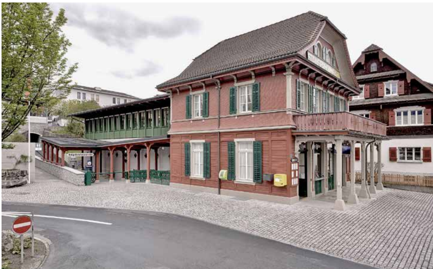
Abb. 2: Die Sanierungsarbeiten, insbesondere die behutsame Integration der Solaranlagen, fügen sich harmonisch und nahtlos in die historische Gebäudestruktur des denkmalgeschützten Bauwerks ein.
