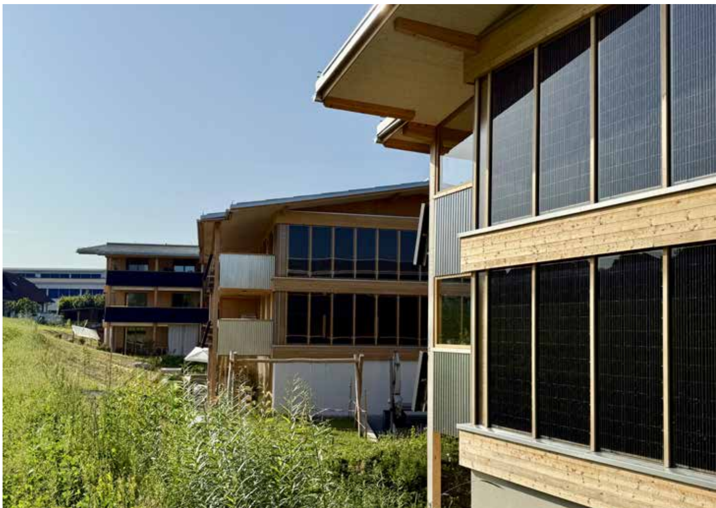
Abb. 2: Neben der Nutzung der Dach- und Balkonflächen zur CO 2 -neutralen Solarstromproduktion wurden ebenfalls wo immer möglich die Fassaden energetisch aktiviert.
