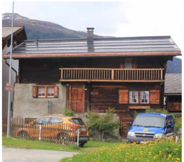
Abb. 4: Das Gebäude nach der Sanierung erstrahlt in neuem Glanz.
