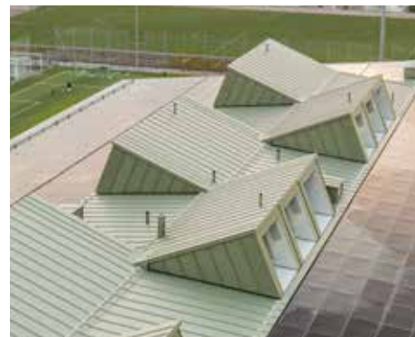
Abb. 1: Eine Nahaufnahme des Daches des Schulhauses Landhaus in Teufen/AR (© Kurzschuss 2025).
