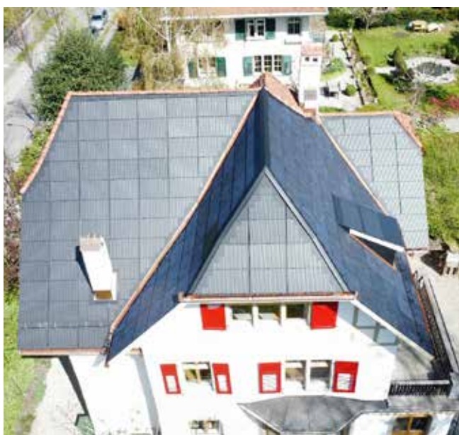
Abb. 3: Die Photovoltaikmodule wurden äusserst sorgfältig in die Dachkonstruktion eingearbeitet, sodass eine Symbiose aus altherkömmlichen Charme und modernen Einzelheiten entsteht.
