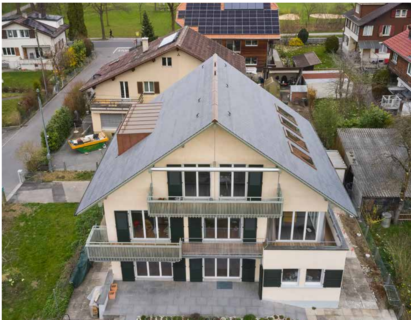
Abb. 2: Durch die Sanierung und Erweiterung des einstmaligen Einfamilienhauses entstand ein PlusEnergie-Gebäude; ein Meilenstein für die Erreichung unserer Klimavorgaben.
