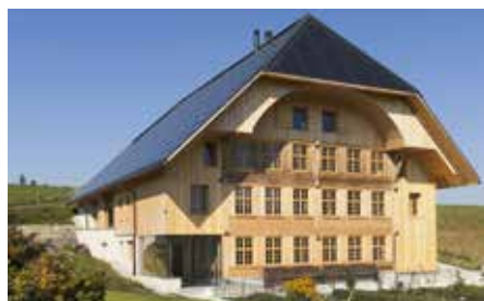
700% PEB-Sanierung, 3416 Affoltern i.E./BE
