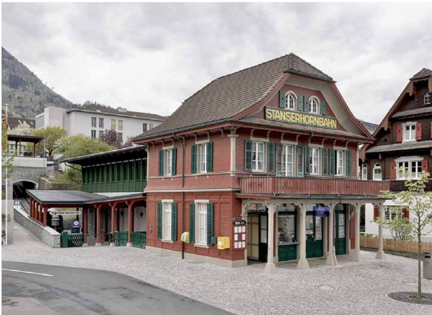
Abb. 2: Die als «national bedeutend» klassierte Talstation der über 130-jährige Standseilbahn behält mit dem sich nahtlos einfügenden Neubau «Remise» seinen ursprünglichen Charakter bei, erzeugt nun jedoch genug CO 2 -freien Strom, um 131% des eigenen Energiebedarfs zu decken.
