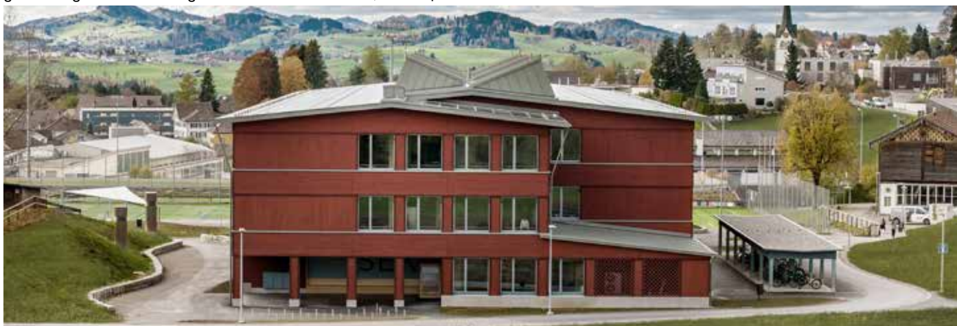
Abb. 1: Aussenansicht des Sekundarschulhauses Landhaus in Teufen mit integrierter Photovoltaikanlage (© Kurzschnitz, 2025).
