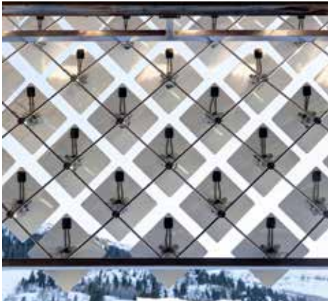
Abb. 1: Ein Blick auf die PV-Module von der Innenseite des Gebäudes (Entwurf: Zurich Soft Robotics; Foto: Bruno Helbling).
