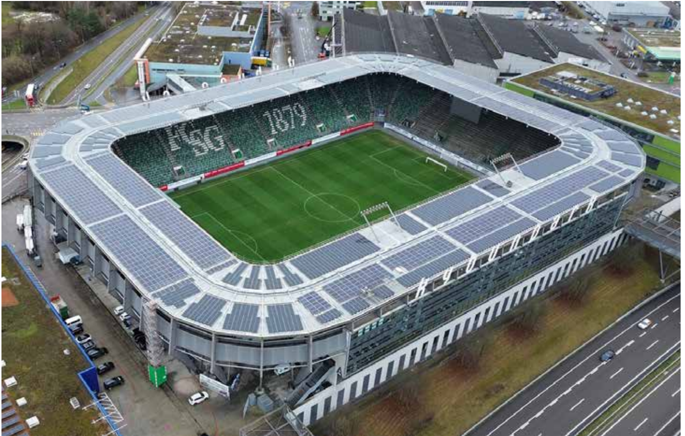
Abb. 2: Der Kybunpark in St. Gallen wurde über mehrere Etappen hinweg mit einer umfangreichen Solarstromproduktion ausgestattet. Dadurch kann das Stadion seinen eigenen Betrieb zu 100% decken und den Überschuss an die benachbarten Gebäude, wie das Einkaufszentrum abgeben.
