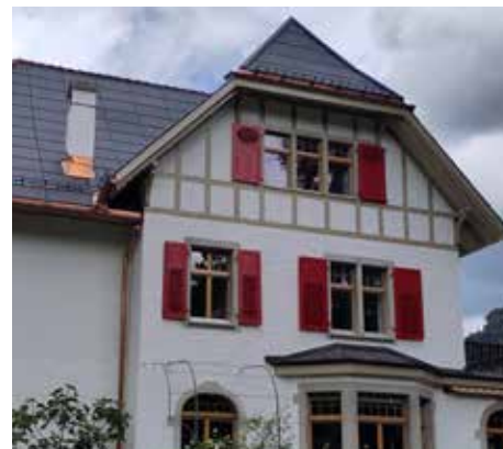
Abb. 1: Die PV-Module fügen sich nahtlos in den Charme des Gebäudes ein.
