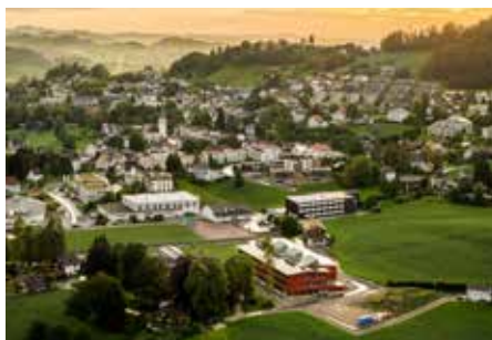
Abb. 3: Schulhaus Landhaus, Teufen/AR (© Kurzschnitt, 2025).
