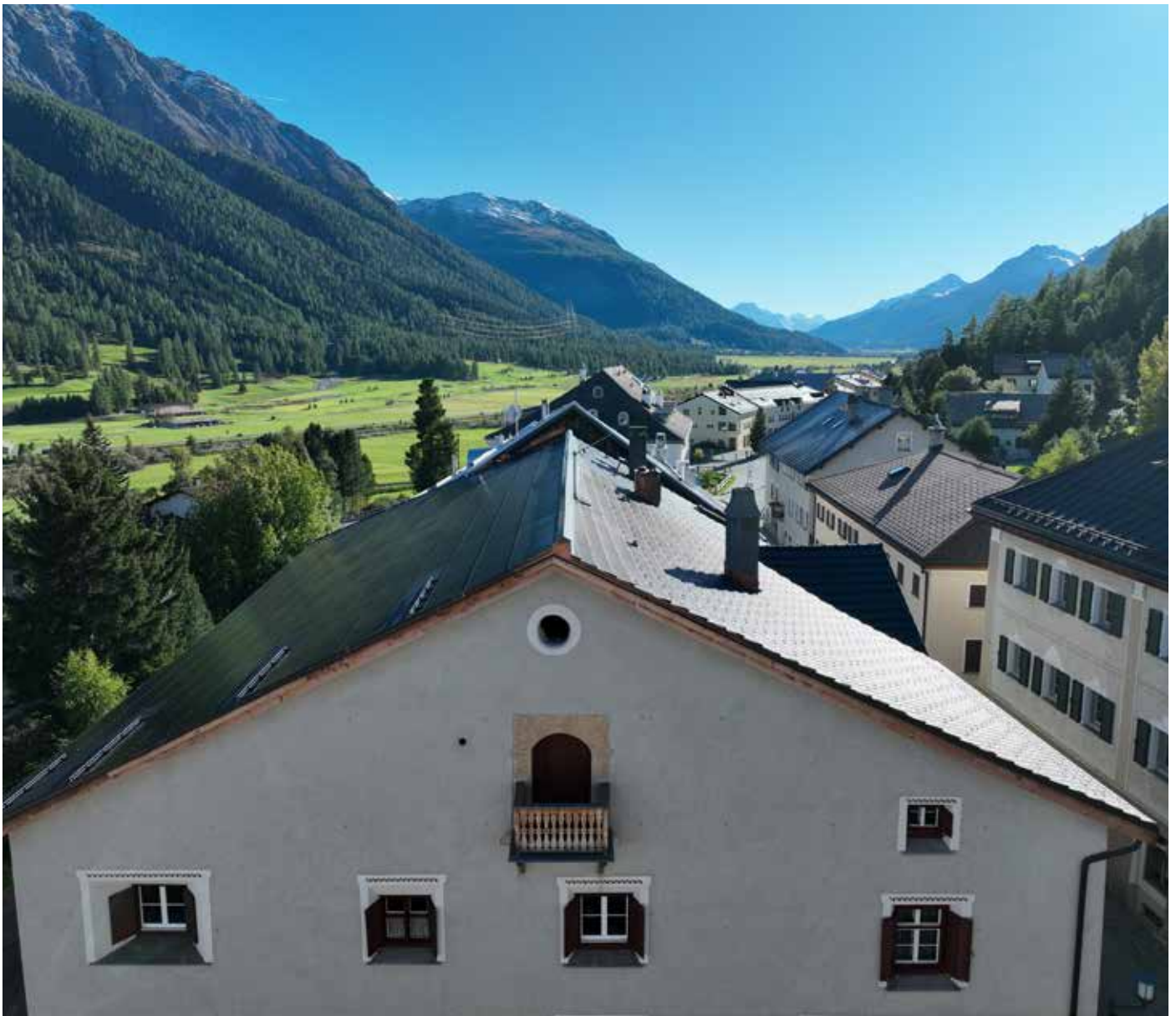
Abb. 2: Das Gebäude in Zuoz erstrahlt in neuem Glanz dank der sorgfältigen und bis ins kleinste Detail geplanten Bestückung der nahezu gesamten Dachfläche mit Photovoltaikmodulen.
