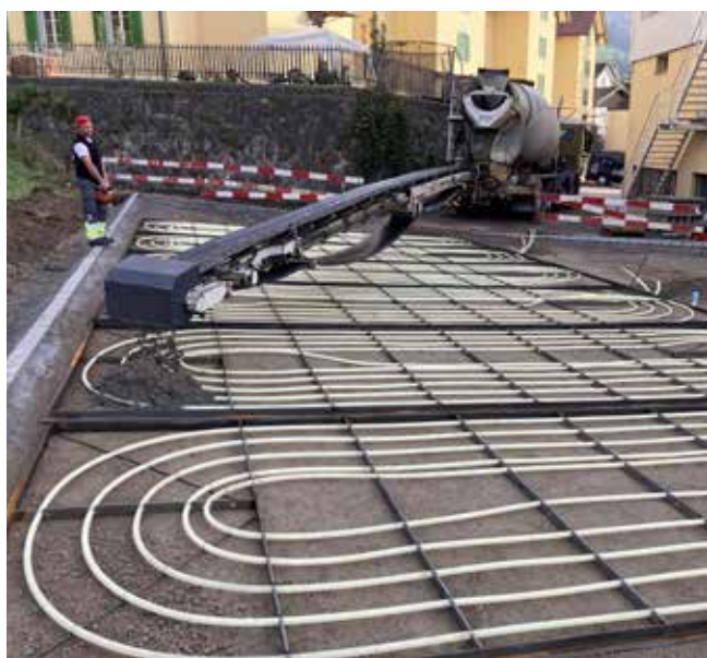
Abb. 3: Die wahre Pionierleistung dieses Projektes ist der Asphaltkollektor.
