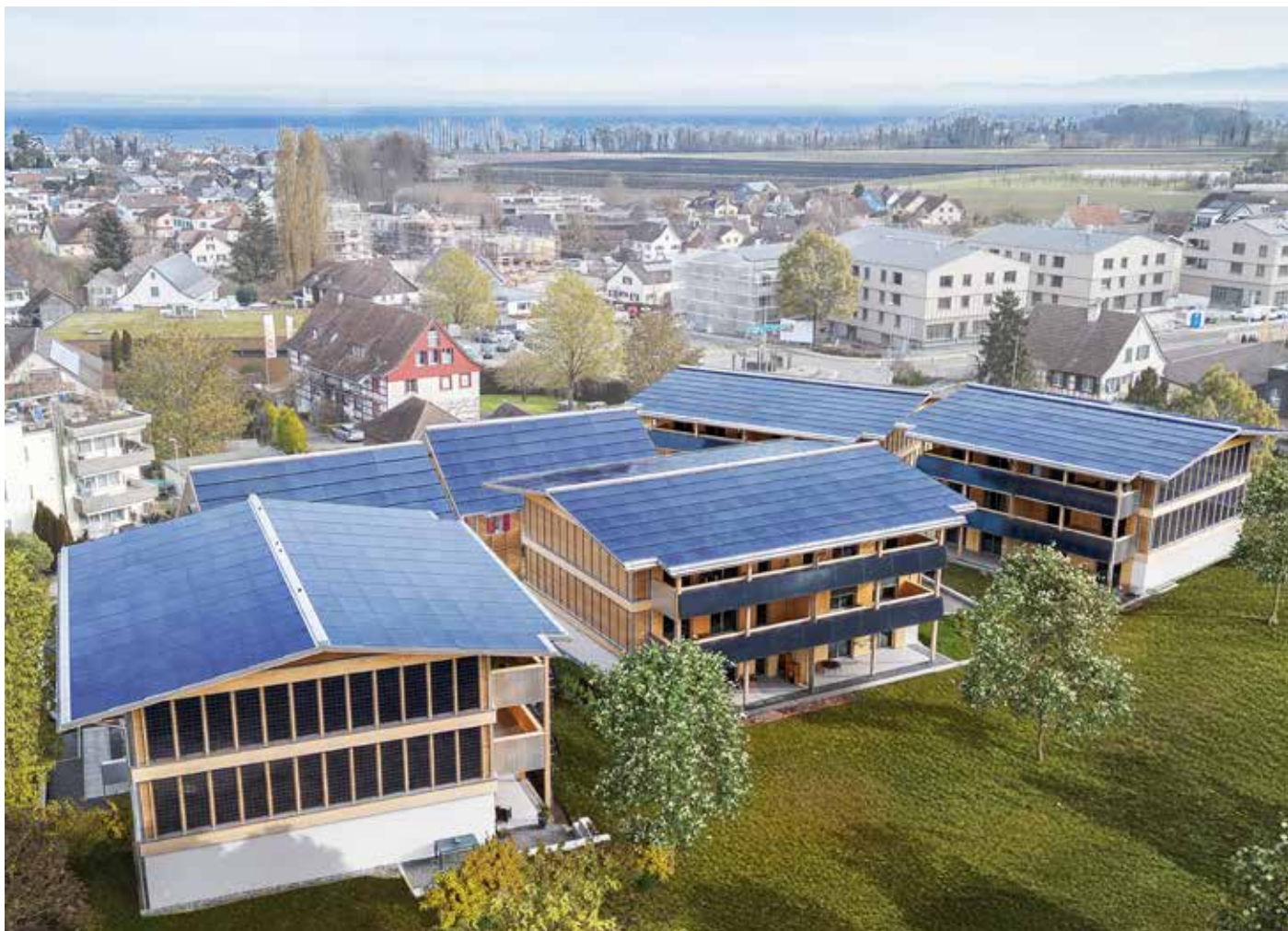
Abb. 3: Das neue Quartier fügt sich harmonisch in das Ortsbild ein und wertet es gleichzeitig durch die sorgfältige und architektonisch überlegte Integration von PV-Modulen auf.
