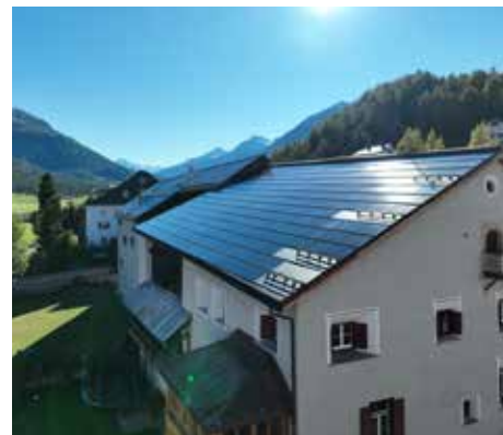
Abb. 1: Eine Nahaufnahme der linken, mit PV-Modulen integrierten Dachfläche.
