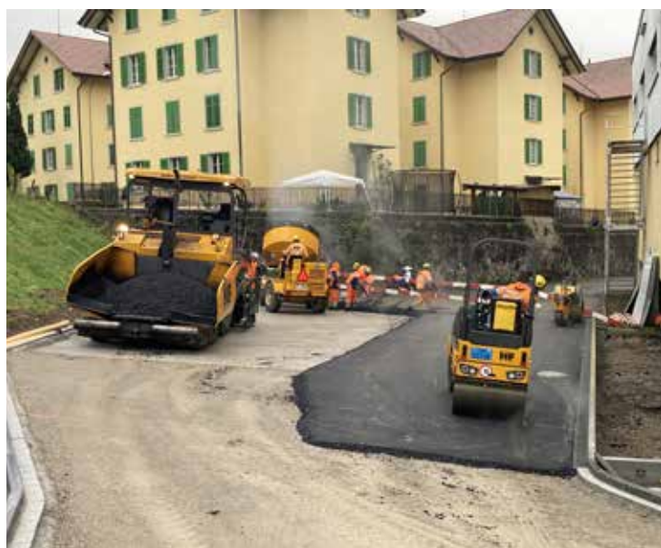
Abb. 4: Der Asphaltkollektor wird asphaltiert, sodass er anschliessend nicht mehr zu sehen ist. Ein unsichtbarer Energielieferant!
