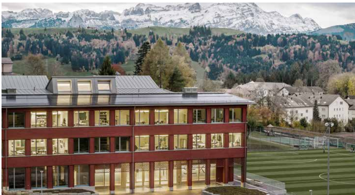
Abb. 3: Dachlandschaft mit grünen Gauben und dachintegrierten PV-Modulen zur aktiven und passiven Solarnutzung (© Kurzschuss, 2025).
