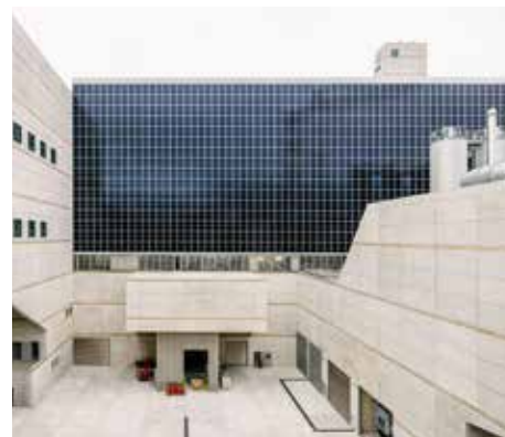
Abb. 1: Die PV-Module wurden ebenfalls Richtung Innenseite der KVA befestigt.
