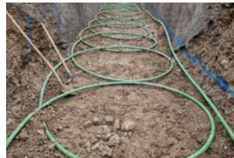
Abb. 1: Der Ringgrabenkollektor verlegt unter den Gleisen ist das innovative Kernelement des Energiekonzepts der Stanserhorn-Bahn.
