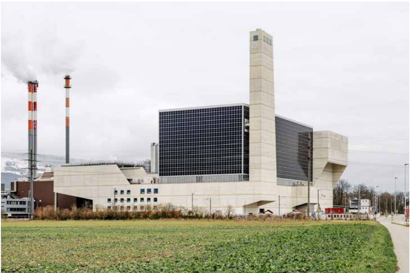
Abb. 2: Die Kehrichtverbrennungsanlage ist durch die grosszügige Verwendung der PV-Module ein Vorbild für ähnliche Gebäudestrukturen!
