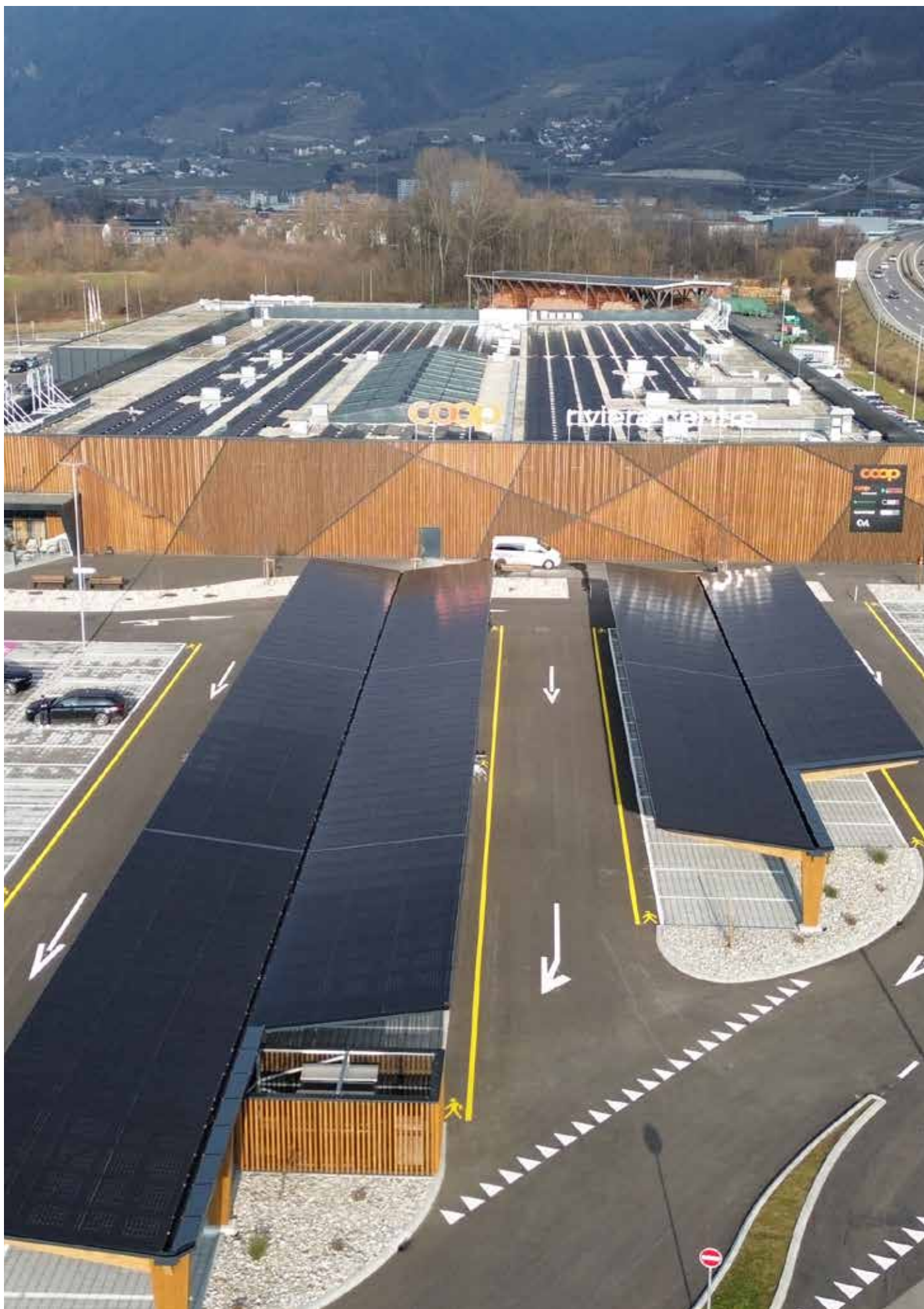
Fig. 1 : le carport de Coop à Rennaz a remporté cette année le diplôme du Prix Solaire Suisse pour une raison décisive : sa construction en bois et l'intégration parfaite des modules photovoltaïques dans celle-ci.
