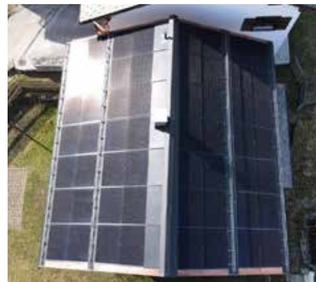
Abb. 1: Eine Nahaufnahme des neuen solareren Daches.
