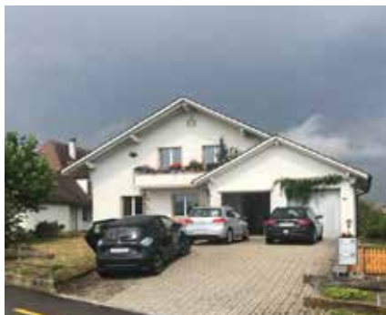
Abb. 1: Das Sanierungs-Projekt vor den Arbeiten.
