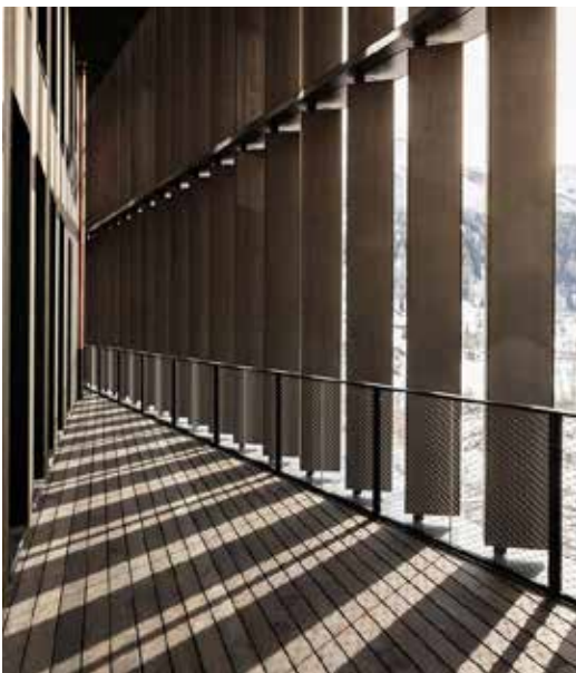
Abb. 3: Die spezielle Anordnung der Fassadenmodule ermöglicht eine hohe Lichtdurchlässigkeit.
