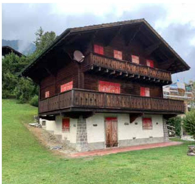
Fig. 3 : le chalet Cosy Corner avant sa rénovation, dans un style alpin classique.
